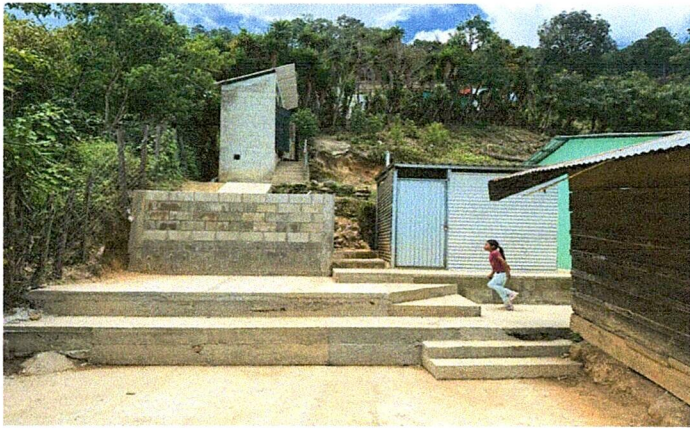
Foto 1: Reparación y sustitución de Área de cocina.
